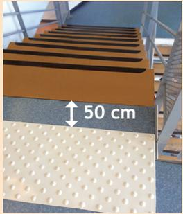
Dalles podotactiles en résine polyuréthane. Teintées dans la masse assurant un système d'éveil à la vigilance au sol, destinées à alerter les personnes aveugles et malvoyantes. Classement Feu M2. Souples, faciles à poser car pré-adhésivées. Bonne résistance à la déchirure. Anti-glisse. Faible encrassement. Bords biseautés. Adhésives sur carrelage, sol résine, sols PVC, Béton lisse, parquet...
